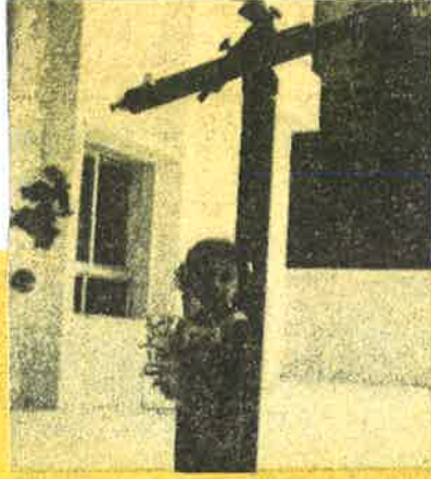
تلسكوب نافذ ٤ بوصة افقي / عمودي الحركة (بعد وارتفاع) مع تلسكوب كاشف ،! والطللة تبين بالمقارنة حجم التلسكوب
